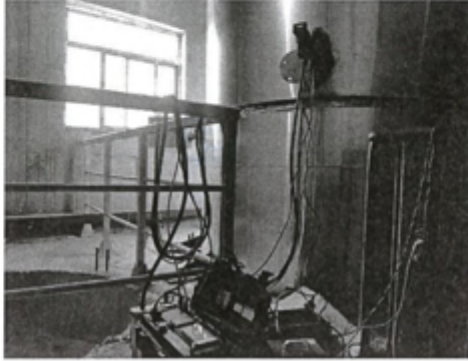
垃圾焚烧炉排口（①#）
