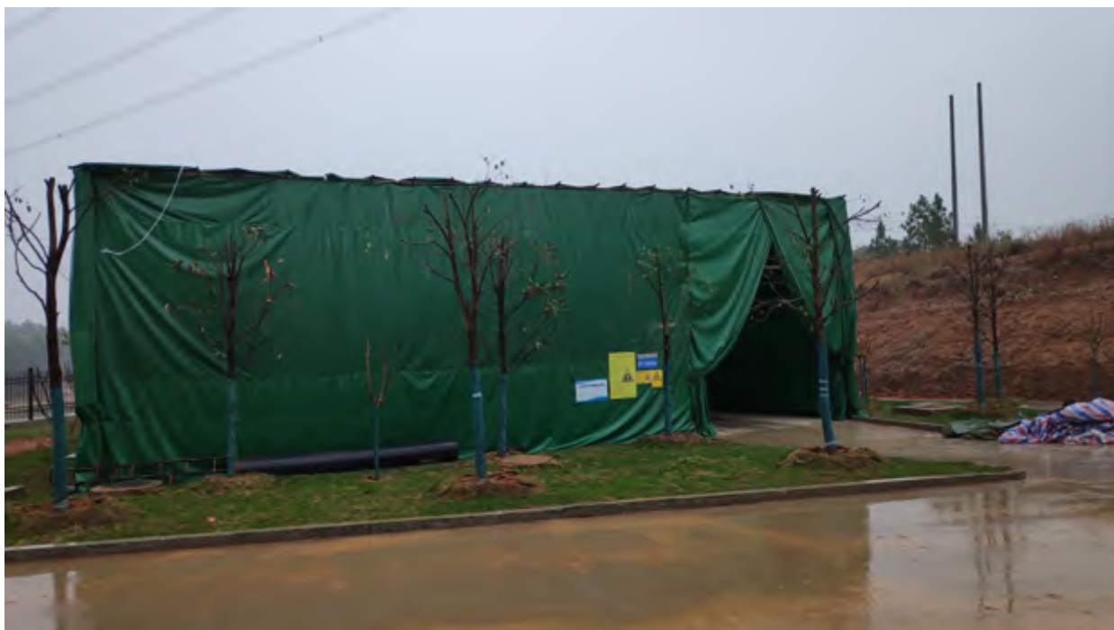
图 4-3 厂区飞灰暂存间
