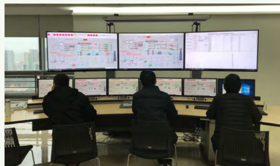
大数据采集监控中心，电厂 DCS 控制系统
